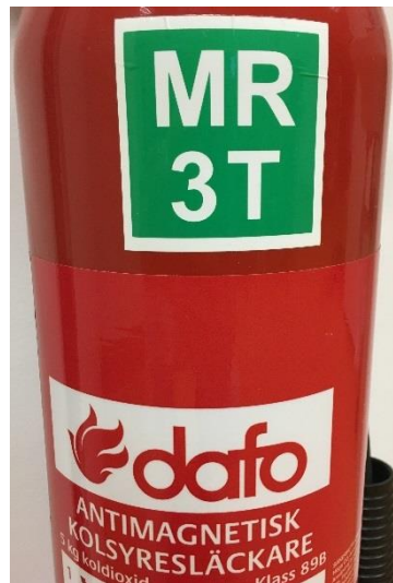
Figur 5 MR-säker brandsläckare på Karolinska, märkt med texten ”ANTIMAGNETISK” samt MR 3T-symbolen vilket visar att den är säker för upp till 3T
