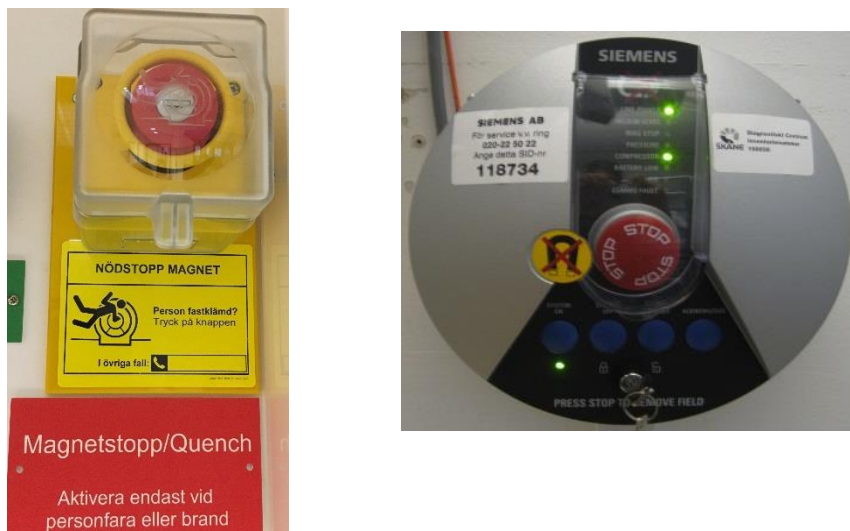
Figur 4 Nödstopp/quenchknapp för magnetfältet. Quenchknappen ska vara skyddad av en plastlucka för att oavsiktlig quench ska undvikas. Bild till vänster: quenchknapp för ett Philips-system, bild till höger: quenchknapp för Siemens-system.
